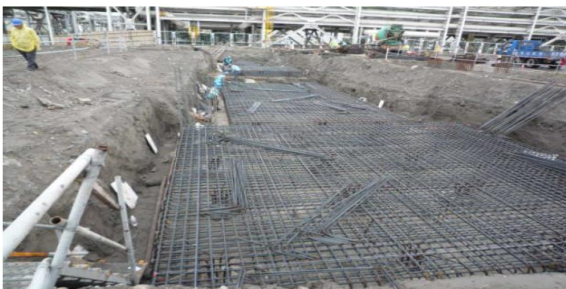
(3) 鋼筋施作工程
