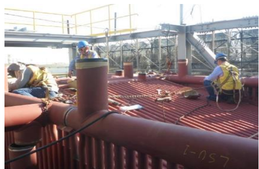
(10) 爐管焊接作業
