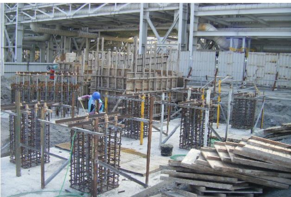
(1) 基礎螺栓埋設
