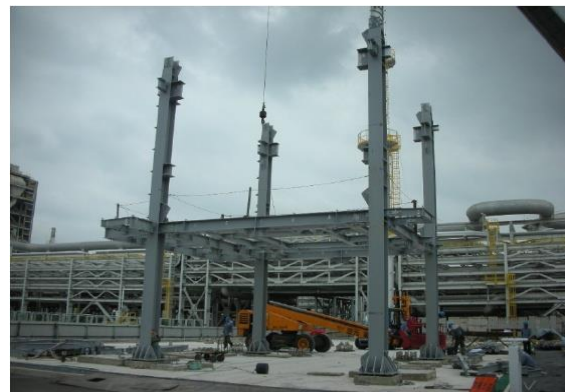
(2) 焚化爐鋼構吊裝
