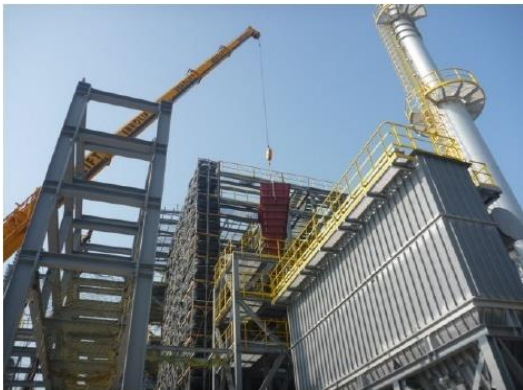
(13) 節熱器管排吊裝
