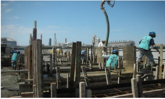
(5) 混凝土澆注工程
