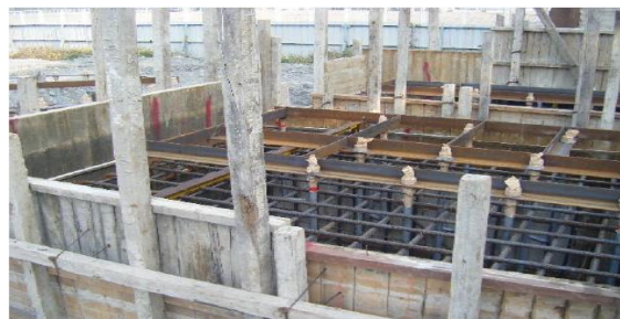
(4) 模板施作工程
