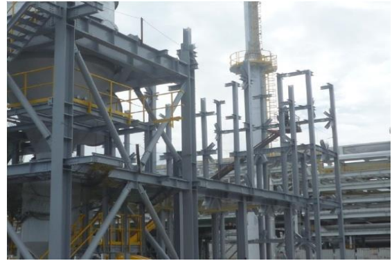
(4) 廢熱鍋爐鋼構吊裝
