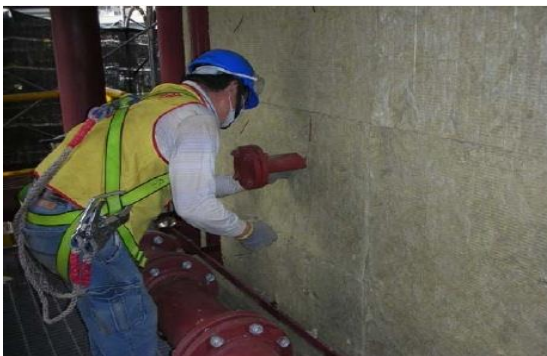
(17) 設備保溫施作
