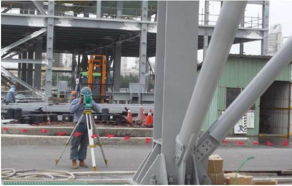
(3) 鋼構垂直度校正
