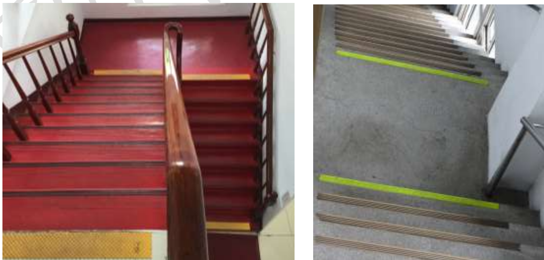
圖 2.10-6 階梯第 1 階及最後 1 階黏貼或油漆如黃色、紅色色帶標示示意圖
