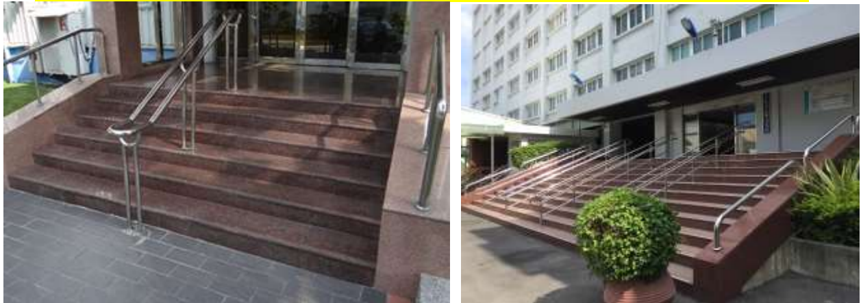
圖 2.10-12 階梯之寬度 \geq 3m 者，應於中間加裝扶手示意圖
