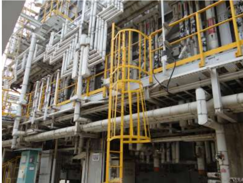
圖 2.10-18 爬梯採 90 度設置示意圖
