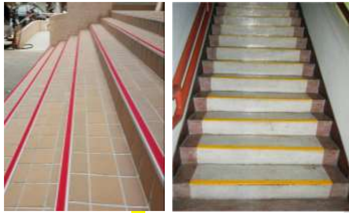
圖 2.10-5 階梯止滑條示意圖
