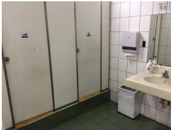
圖 2.10-7 廁所有設置階梯者於階梯第 1 階及最後 1 階黏貼黃色反光止滑條
