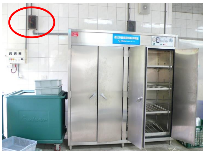
圖 2.3.1 設備電源經漏電斷路器供電
