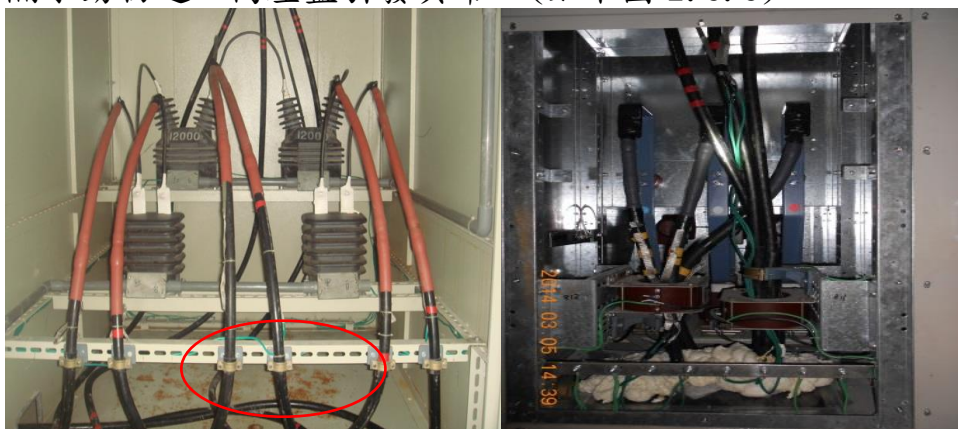
圖 2.3.2 電纜固定座接地
