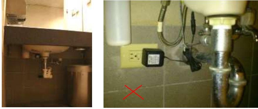
圖 2.3.17 舊型電壓轉換器(Adapter)直接插接於牆面插座，易因本體重量或插座張力疲乏而下垂或接觸不良。
