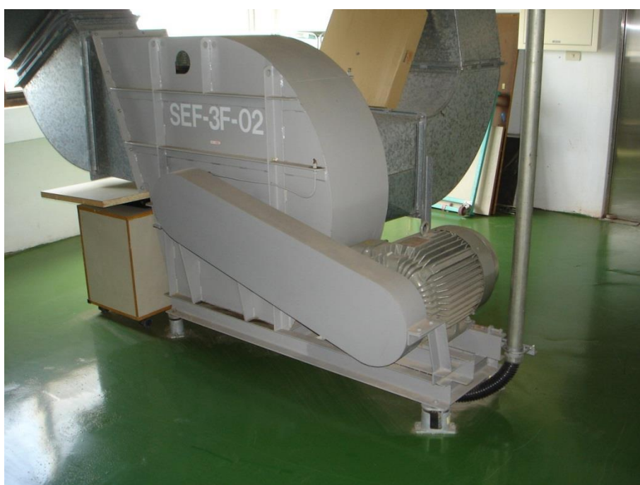
圖 2.3.5 落地式風機安裝詳圖
