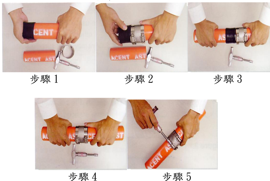
圖 2.3.1 鑄鐵管施工步驟圖(參考 ACENT 公司)
