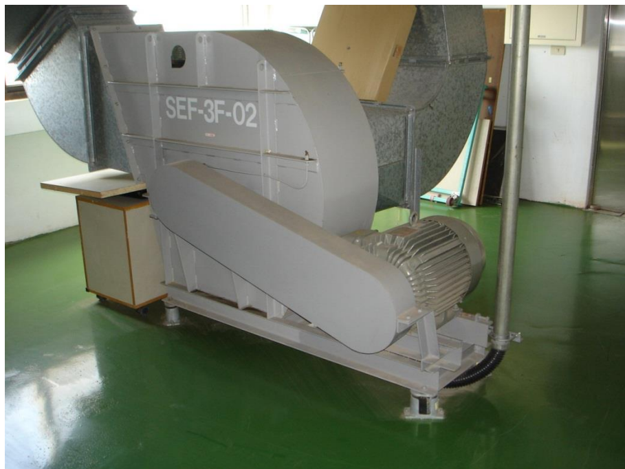
圖 2.3.23 落地式風機安裝詳圖
