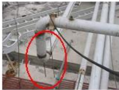
圖 2.3.5 支撐點焊於母材 圖 2.3.6 支撐點焊於法蘭
