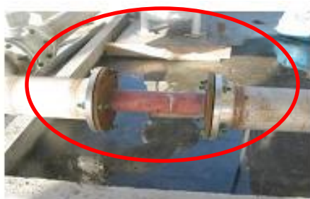
圖 2.3.7 以短管代替儀錶洗管示意圖
