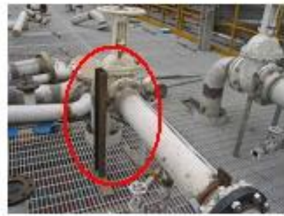
圖 2.3.5 支撐點焊於母材 圖 2.3.6 支撐點焊於法蘭
