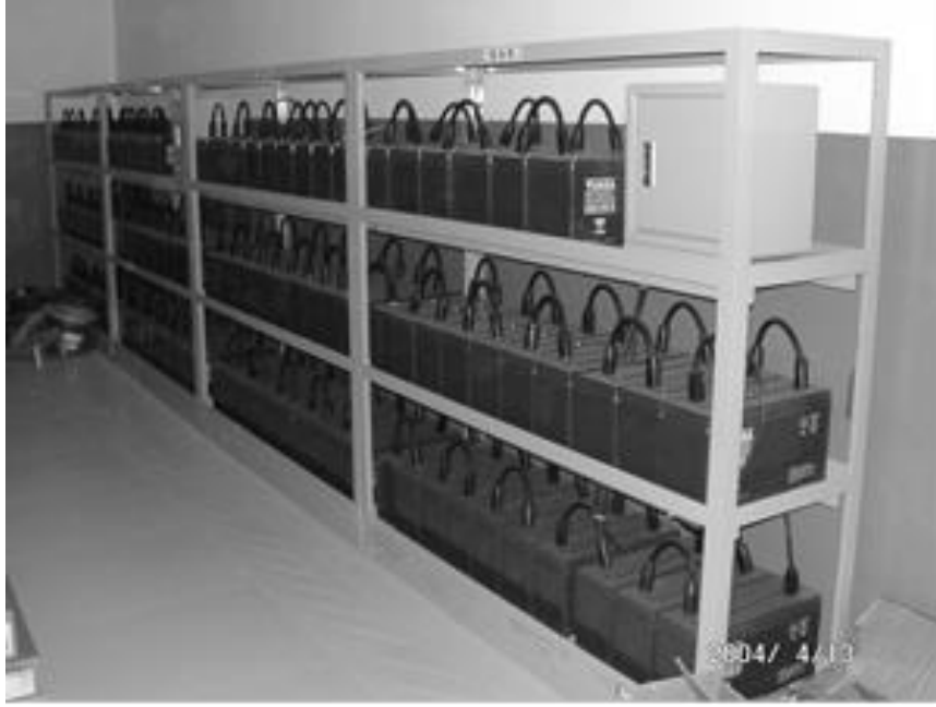
圖 2.3.4 UPS 電池架
