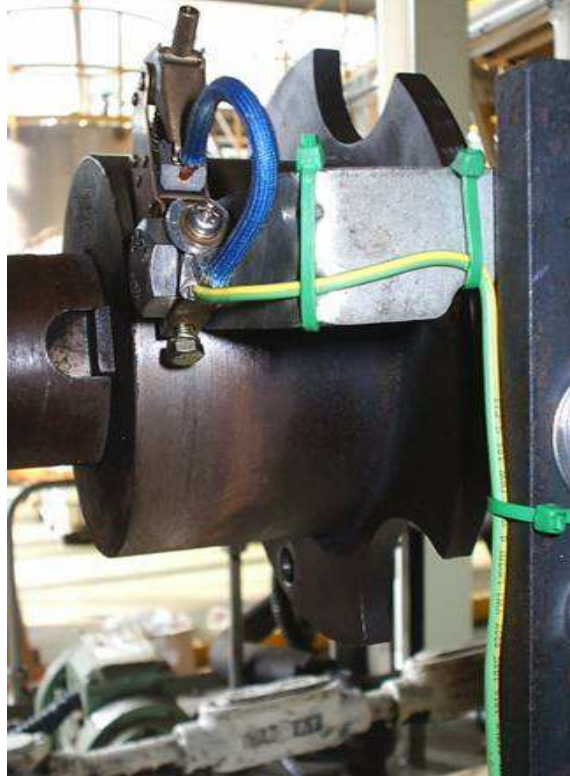
圖 2-27 電動機轉軸安裝接地碳刷
