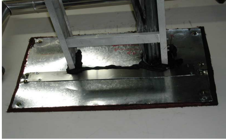
防火板接合處覆蓋切口連接片
