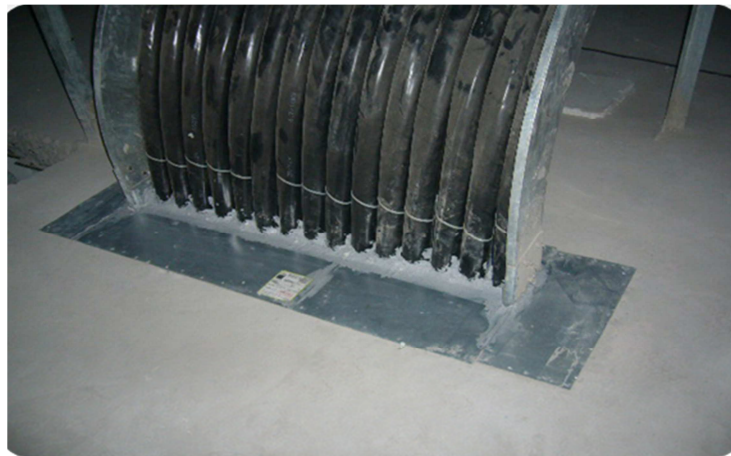
電纜架貫穿樓板以防火板施工完成照片
