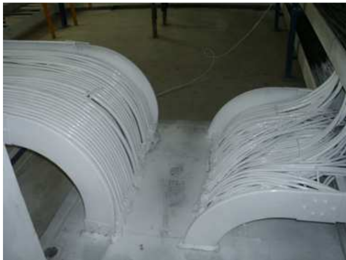
電纜架貫穿樓板，距離樓板 1m 內噴塗防火塗料
