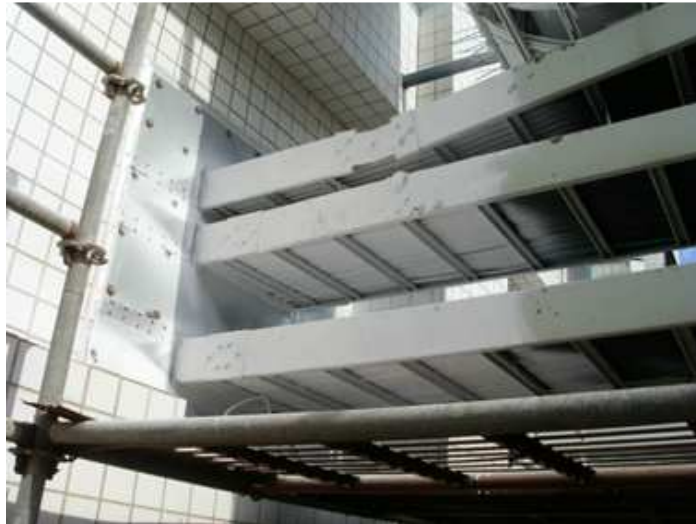
電纜架貫穿防火區劃牆壁，距離牆壁 1m 內噴塗防火塗料
