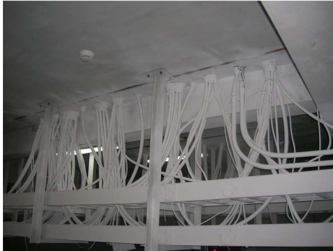
配電盤下方電纜噴塗防火塗料
