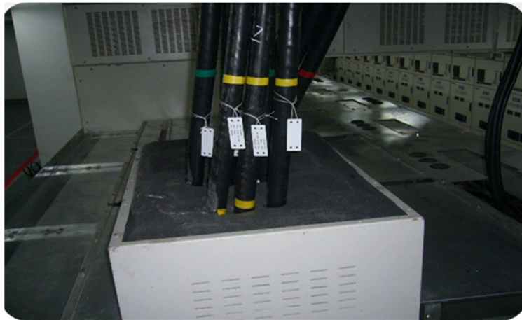
配電盤上進線兩劑型阻火發泡材料施工完成照片
