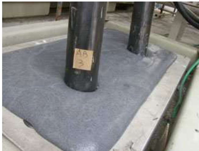
兩劑型阻火發泡材料施工完成照片
