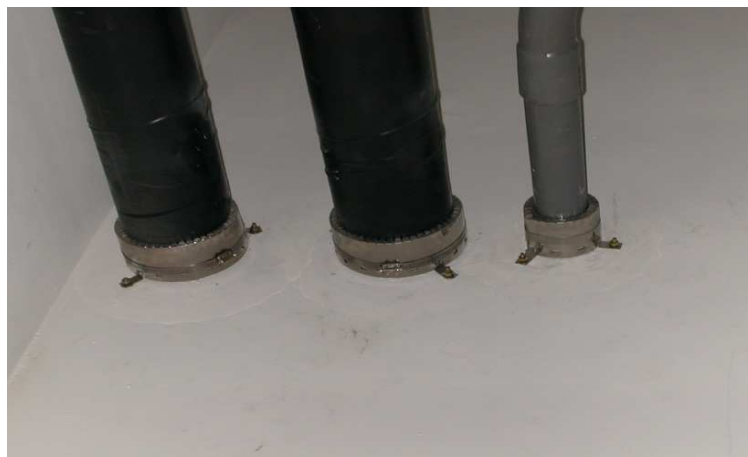
使用套環組施工完成照片
