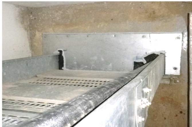
電纜周圍充填非凝固型防火泥
