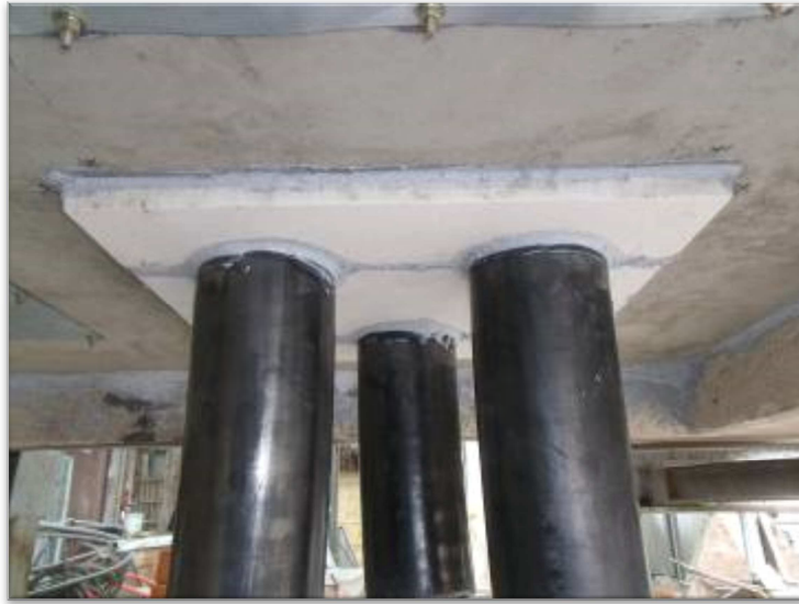
陶瓷纖維板放置於貫穿開孔底部，以防火矽利康填補縫隙
