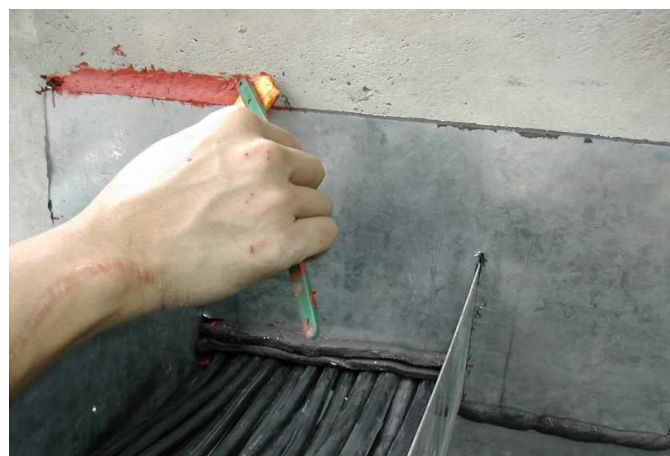
防火板周圍充填凝固型防火泥
