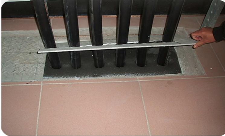
兩劑型阻火發泡材料施工完成照片
