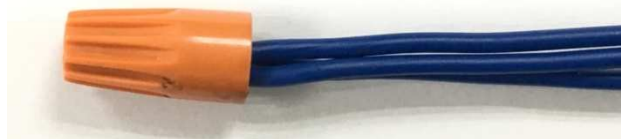
步驟一：使用彈簧螺式接頭接線完成
