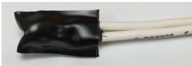
圖4.7-7 電線剝除絕緣後直接絞接，再包覆06147自融性防水膠帶
