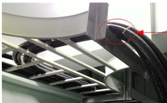
圖4.7-1 電纜架使用垂直可調連接片時電纜受損示意圖
