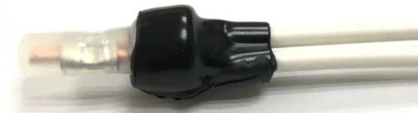
圖4.7-6 使用閉端端子接線，再包覆06147自融性防水膠帶
