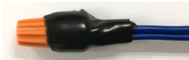
步驟二：彈簧螺式接頭接線完成再包覆 06147 自融性防水膠帶
