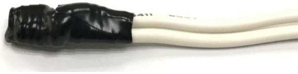
步驟二：絞接處纏繞 PVC 絕緣膠帶
