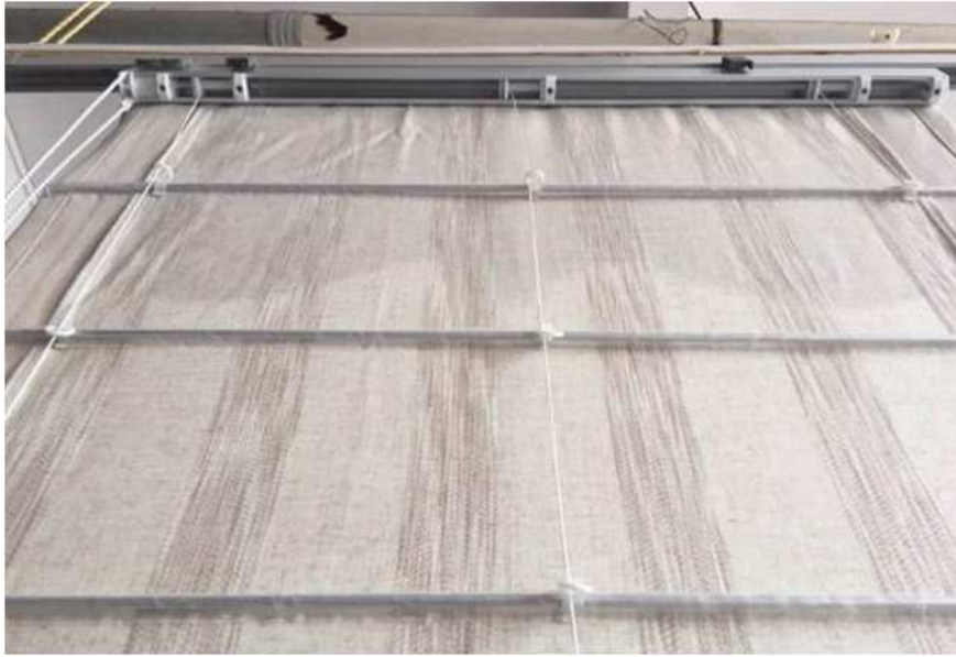
圖 2.2.3-5 羅馬簾之軌道及其它配件(背面參考構造圖,手動)
